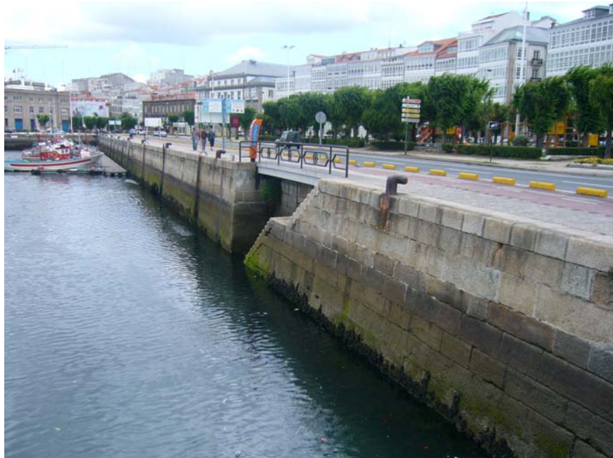
Figura 3. Vista del tramo de estudio del muelle Norte (lado galerías).
